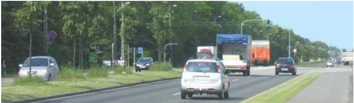
Foto: Roskildevej i Albertslund på en delstrækning, hvor Københavns Amt har påbegyndt en ombygning af vejen.
